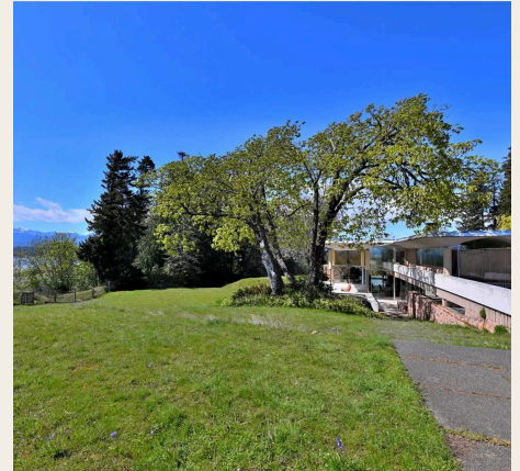
Prado e vista costeira na Filberg House
